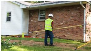
Los conductores sin energía y energizados o los objetos energizados presentan el riesgo de descarga eléctrica por tensión de paso.
